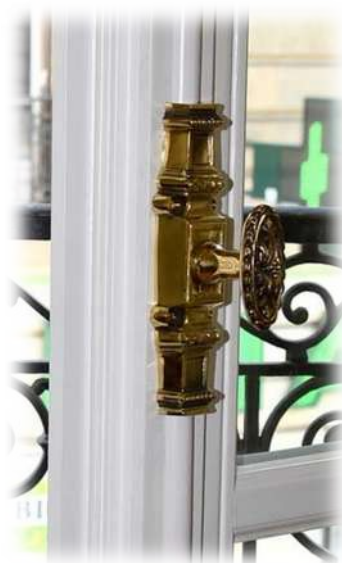
Récupération des anciennes crémones
